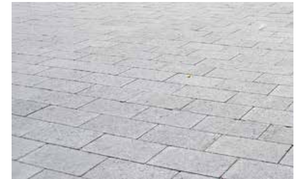
Betongmarksten på gångar och platser
